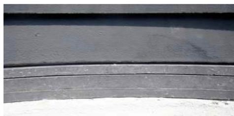
**foto 2** Utilizzo tipico degli anelli del sistema TVR T nelle strutture in cemento dei dispositivi di coronamento, come elementi di regolazione dell'altezza del chiusino e come ammortizzatori. Gli anelli distanziali in plastica di 15 30 40 mm e anelli cunei T1K 600/9/22, T1K 625/9/22 e T1K 635/30/60 mm eliminano l'impiego di malte cementizie e costituiscono una possibile regolazione complementare.
