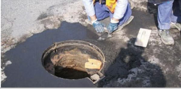
Malta premiscelata a presa rapida per il fissaggio di chiusini stradali e per la manutenzione delle pavimentazioni industriali
