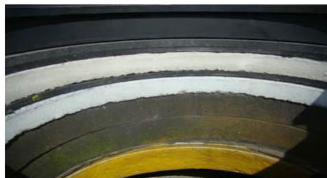
**foto 1** Struttura del dispositivo di coronamento basata su anelli distanziali in cemento alternati con quelli in plastica, senza l'utilizzo di malte cementizie. Il materiale sigillante sono le masse polimeriche. Il chiusino viene posto dopo la regolazione dell'altezza e dell'angolo d'inclinazione. Regolazione dell'altezza: 35 cm.
