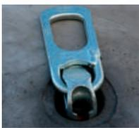
La movimentazione e la posa degli elementi vengono effettuate in sicurezza e velocità con il sistema di sollevamento rapido marchiato CE che non prevede pezzi saldati o avvitati per cui sono esclusi i rischi connessi ad imperfette avvitature ed usure dei filetti. Le operazioni d'innesto e disinnesto del gancio sono istantanee grazie agli speciali chiavi annegati nel getto che ricevono gli appositi maniglioni.
